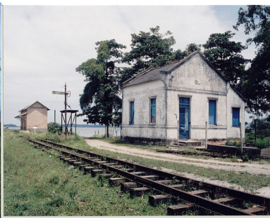
2 - Antes da instalação da PETROBRAS
