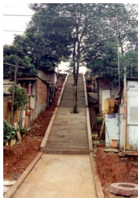
fotos 93, 94, 95 e 96. Urbanização Integrada do Núcleo Tamarutaca - PIIS: Demolição dos barracos e remoção das famílias para viabilizar desadensamento, abertura de sistema viário e construção de vias de acesso - escadaria (durante e depois da obra)
