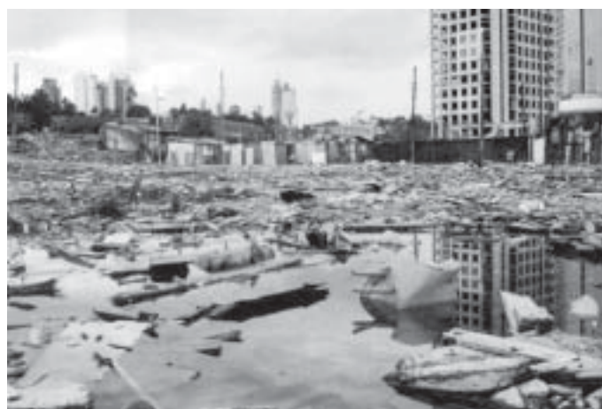
fotos 42 e 43. Vista aérea e detalhe da Favela Jardim Edith removida para a construção da Avenida das Águas Espraiadas - São Paulo. 1996
