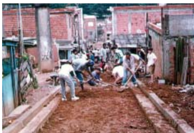
foto 51. Núcleo Vila Olinda: mutirão para execução de pavimentação. 1995
