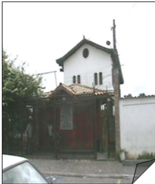
Figura 2 - Estrutura física - visão da entrada
