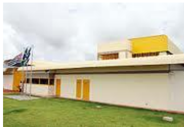
Figura 4: Fachada do modelo T 40 da Fundação CASA.
