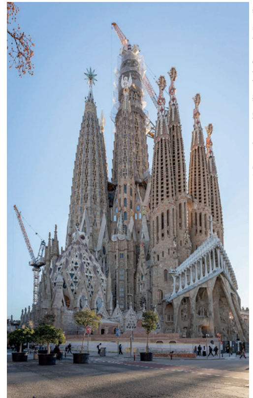
Visão externa das torres e fachadas, inspirada em elementos da natureza
