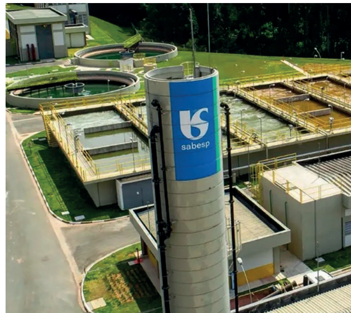
Estação de Tratamento de Esgoto (ETE) Caieiras
