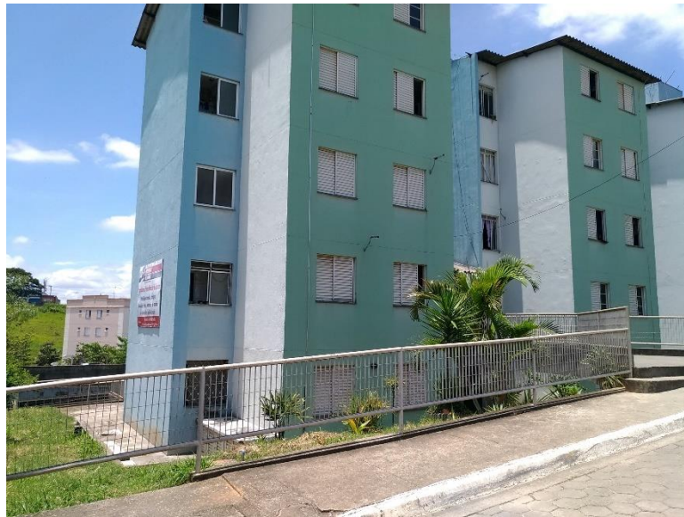
Figura 12 - Vista lateral do Condomínio 3
