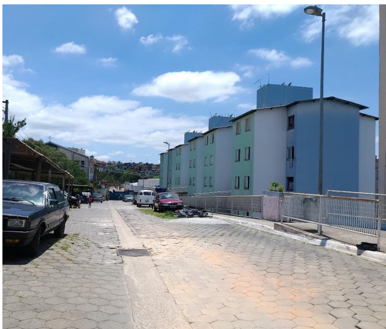
Figura 13 - Espaço coletivo do Condomínio 3
